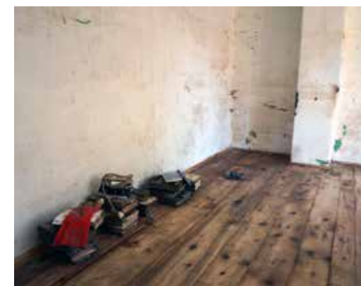
Vyčistěte stěny a podlahu, jak nejlépe můžete.
