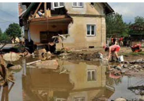
V okolí staticky narušených budov se pohybujte se zvýšenou opatrností. Zřícení takovýchto domů probíhá rychle a může nastat znenadání. Zabraňte též přístupu dalších osob.
