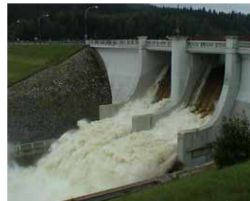
Jedním z účelů vodních nádrží je transformace povodňové vlny díky objemu ochranného prostoru, ve kterém je za povodni zadržována voda. Lipenská přehrada vypouští vodu během povodni v roce 2002.
