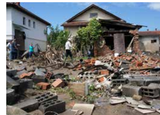
Drobné stavby jsou zvláště náchylné k poškození. Při jejich ohledání postupujte s největší opatrností, k jejich zřícení mnohdy stačí otevřít dveře.
