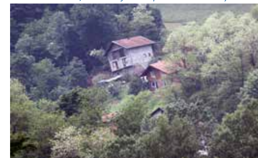
Vydatné srážky mohou způsobit nestabilitu svahů a jejich celé sesuvy i se stavbami na nich.
