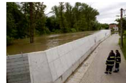
STRUKTURÁLNÍ PROTIPOVODŇOVÁ OPATŘENÍ PEVNÉ VALY A ZDI
