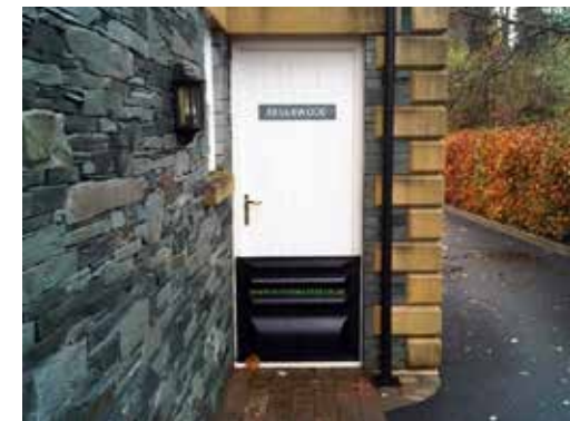
Demontovatelná zábrana na vstupní dveře zabraňující vniknutí vody.
