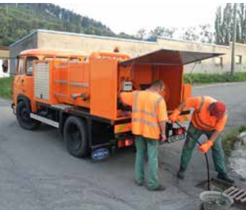
Zkontrolujte a podle potřeby nechte vyčistit kanalizaci.
