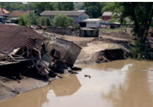
Velká povodeň dokáže odnést celý dům.
