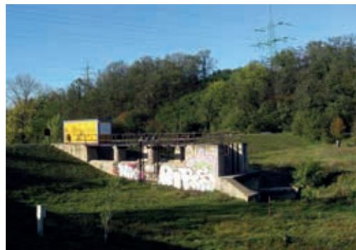
Suché nádrže slouží k zadržení vody za povodní. Suchá nádrž Čihadla.
