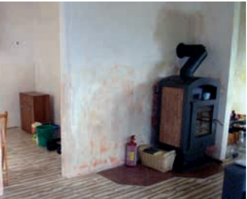
Zprovozněte topení i provizorně a zatopte, výrazně tak urychlíte vysoušení stavby
