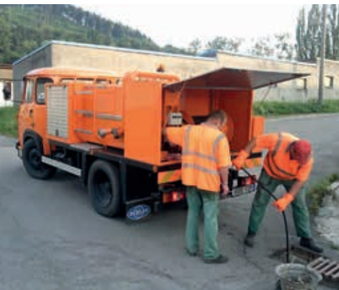
Zkontrolujte a podle potřeby nechte vyčistit kanalizaci.
