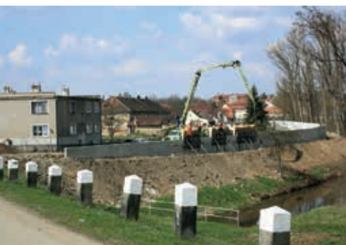
Ochranné hráze a zdi jsou finančně náročné liniové stavby, které se používají většinou při ochraně měst. Výstavba hráze v Hořině.
