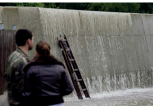
Protipovodňové zdi a valy neposkytují stoprocentní ochranu. Zeď v Hoříně, když přetekla za povodně v roce 2013.
