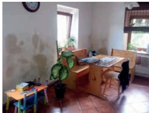
Uspěchaní oprav a předčasné zabydlení vede k vystoupení vlhkosti ze zdiva na opravený povrch.
