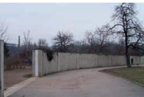
Protipovodňové zdi jsou mnohdy terčem kritiky obyvatel měst, že jsou nehezské. Libeňský ostrov. Stezka podél protipovodňové zdi.
