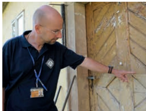
zjišťují míru zaplavení a poškození domácnosti,
