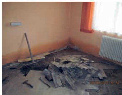
Parquetové a plovoucí podlahy je potřeba odstranit.
