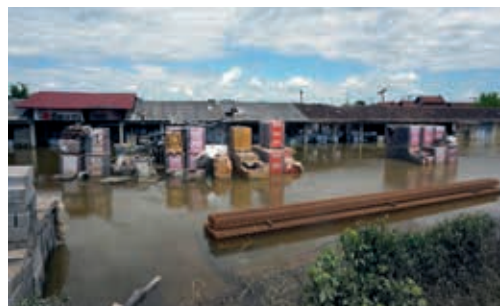
Povodně se neomezují pouze na obytné domy.
