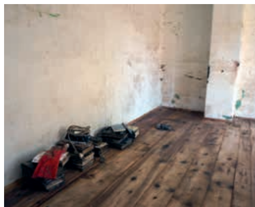
Vyčistěte stěny a podlahu, jak nejlépe můžete.
