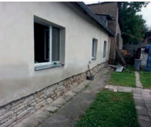
Odstraňte venkovní omítku soklu a nepropustný okapní chodníček pro lepší vysychání stavby.
