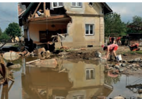
V okolí staticky narušených budov se pohybujte se zvýšenou opatrností. Zřícení takovýchto domů probíhá rychle a může nastat znenadání. Zabraňte též přístupu dalších osob.
