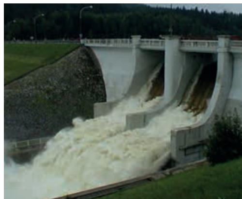
Jedním z účelů vodních nádrží je transformace povodňové vlny díky objemu ochranného prostoru, ve kterém je za povodní zadržována voda. Lipenská přehrada vypouští vodu během povodní v roce 2002.
