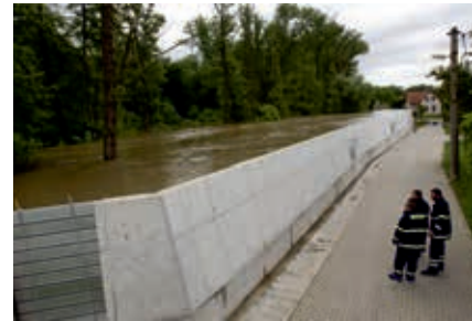
STRUKTURÁLNÍ PROTIPOVODŇOVÁ OPATŘENÍ PEVNÉ VALY A ZDI
